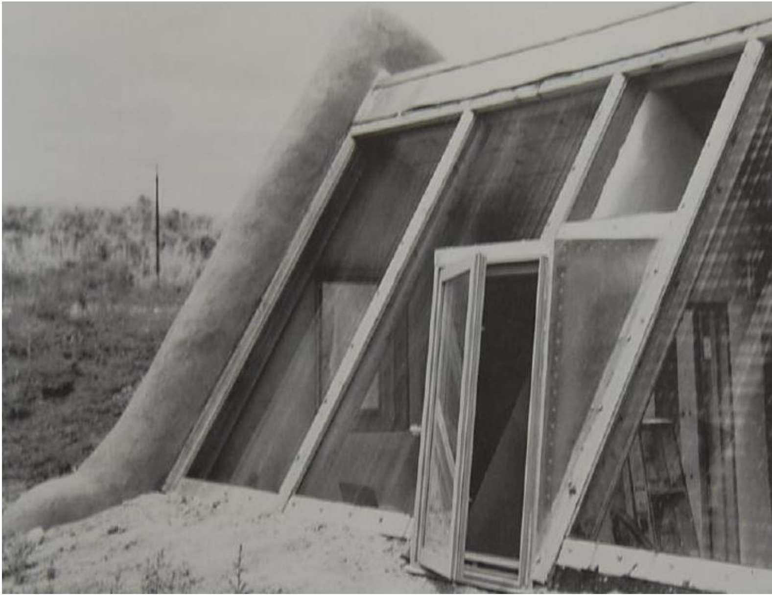
Invernadero terminado. Exterior.
